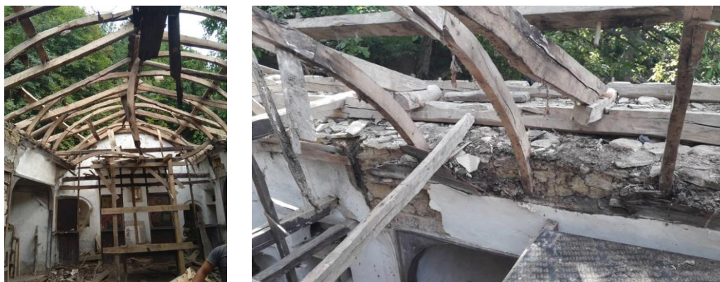
Фиг. 13. Изпълнение на демонтажни работи на храм „Свети Никола“ – детайли
