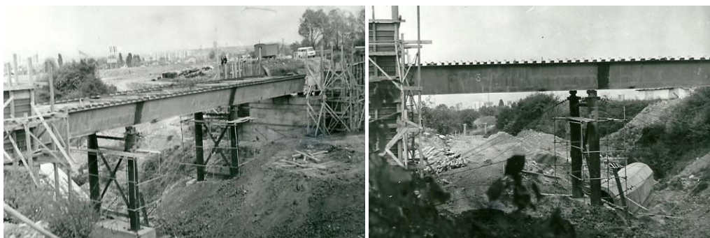
Фиг. 5. Временни опори за монтаж на стоманената конструкция
