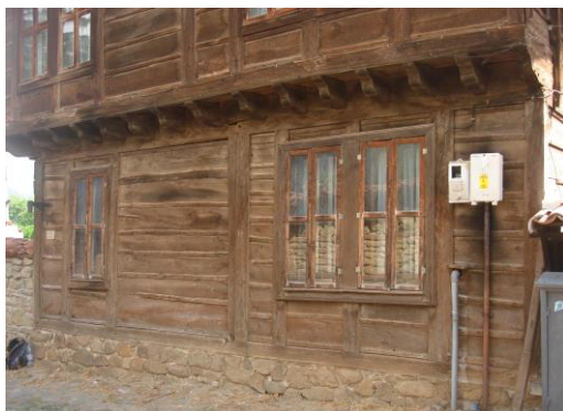
Фиг. 1. Летви, наковани върху фугите от външната страна на талпите. Между най-горните талпи и горните греди на приземното ниво на къщата има фуга, показваща, че талпите не участват в поемането на вертикалния товар
