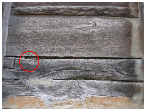
Фиг. 6. Дървена клечка, свързваща долна талпа с долна греда (ляво) и летви, затварящи фугата между талпите от външната страна, които не изпълняват конструктивна функция (дясно)
