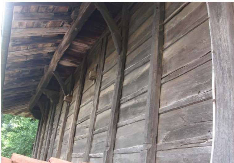
Фиг. 5. Притисквачи, които служат за опора на подкосите, подпират стрехата
