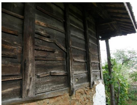
Фиг. 6. Дървена клечка, свързваща долна талпа с долна греда (ляво) и летви, затварящи фугата между талпите от външната страна, които не изпълняват конструктивна функция (дясно)
