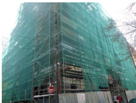
Фиг. 1. Покрито с предпазна мрежа фасадно скеле
