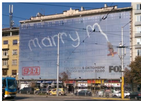
Фиг. 2. Покрито с рекламна предпазна мрежа фасадно скеле
