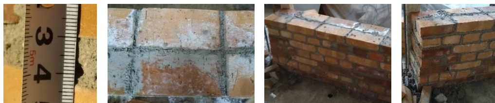
Фиг. 6. Дебелина на фугите и запълване на вертикалните фуги
