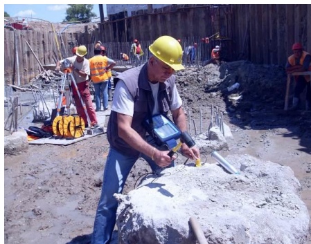
Фиг. 42 и 43. Общ вид на изпълнените пилоти за стълб P1 и момент от комбинираното изпитване на интегритета им по двата метода – с „TDR 2“ и „Ultrasonic Cross hole Testing“ (на заден план)
