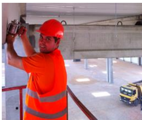
Фиг. 37, 38 и 39. Момент от провеждане на контрола и радиографски картини на анкерните болтове и напрягащите въжета в областта на връзката „стоманена колона – напрегната ст.б. столица“ в склад на „Макском“ ООД край гр. Пловдив
