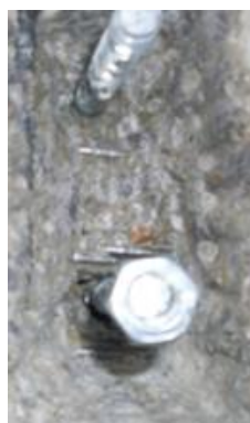
Фиг. 37, 38 и 39. Момент от провеждане на контрола и радиографски картини на анкерните болтове и напрягащите въжета в областта на връзката „стоманена колона – напрегната ст.б. столица“ в склад на „Макском“ ООД край гр. Пловдив
