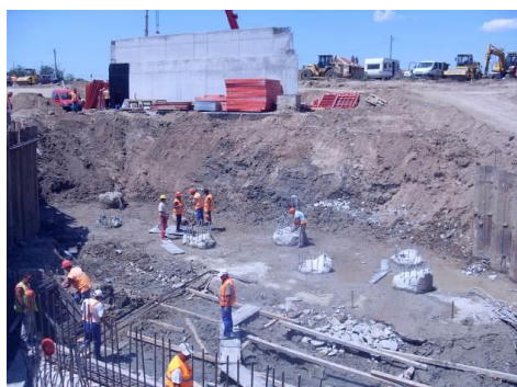
Фиг. 42 и 43. Общ вид на изпълнените пилоти за стълб P1 и момент от комбинираното изпитване на интегритета им по двата метода – с „TDR 2“ и „Ultrasonic Cross hole Testing“ (на заден план)
