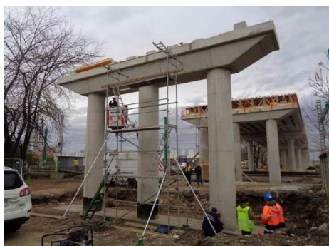
Фиг. 62 и 63. Моменти от проведените ултразвукови изследвания на еднородността и якостно-деформационните характеристики на бетона в ст.б. колони на пътен надлез Стамболийски (2017 г.)
