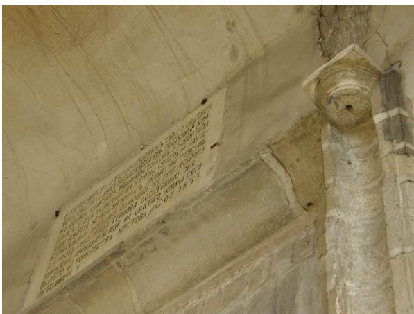
Фиг. 5 и 6. Фрагмент на входната врата (ляво) и детайл на леглото и връзката с каменната стена на липсващите вече въртящи се колони
