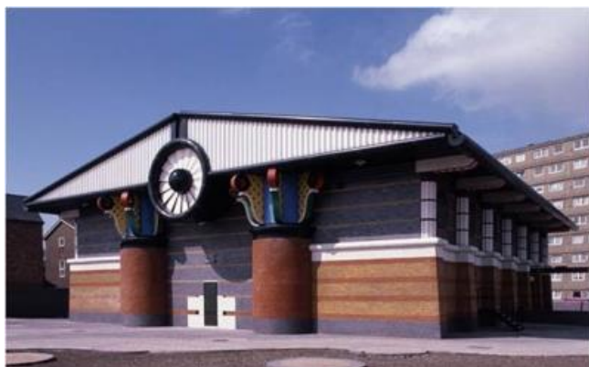
Фиг. 10. Помпена станция на „Островът на кучетата“ Лондон
