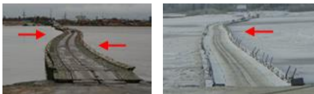
Сн. 13. Възможни деформации при плаващ мост лента
