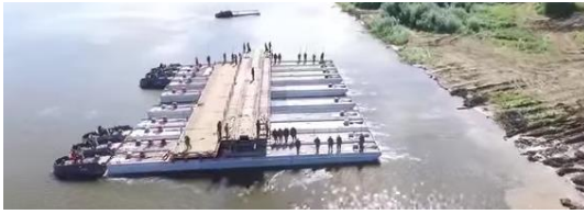
Сн. 7. Устройване на плаващ мост НЖМ-56 от предварително сглобени звена, Русия 2016 г.
