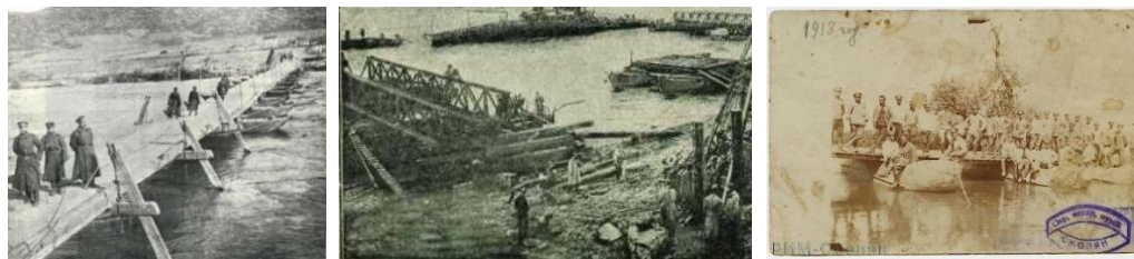
Сн. 1. Комбиниран понтонен мост на р. Вардар при гара Удово (Македония), построен от 1-ва понтонна рота по време на Първата световна война (ляво); строителството на моста Свищов – Зимница от български и германски войски през 1916 г. (център); пионерната дружина на 10-та Беломорска дивизия при понтонния мост на р. Ангиста, Драмско, 23.VI.1918 г., инв. № К-371, РИМ-Смолян (дясно)
