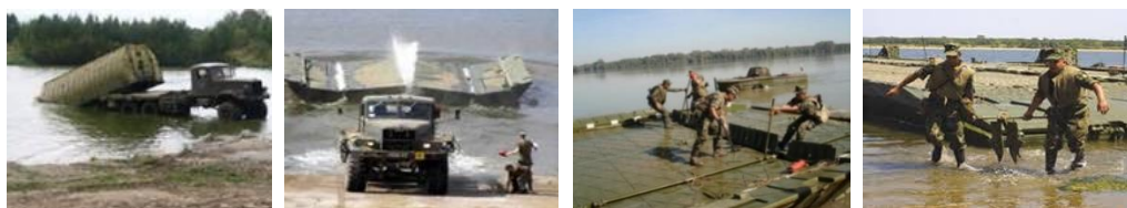
Сн. 8. Моменти от работната процедура по устройване на плаващ мост лента
