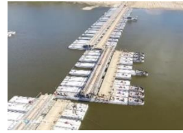
Сн. 7. Устройване на плаващ мост НЖМ-56 от предварително сглобени звена, Русия 2016 г.
