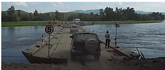
Сн. 5. Плаващ мост лента за постоянно използване в Монголия, изпълнен от щатен мостови парк
