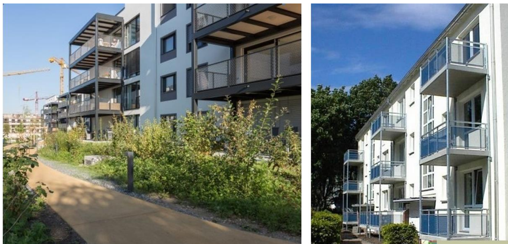
Фиг. 6. Обемни секции на балкони, апликирани към фасади с непрекъсната топлоизолация, Германия (вляво – ново строителство, вдясно – ремонт и реконструкция)
