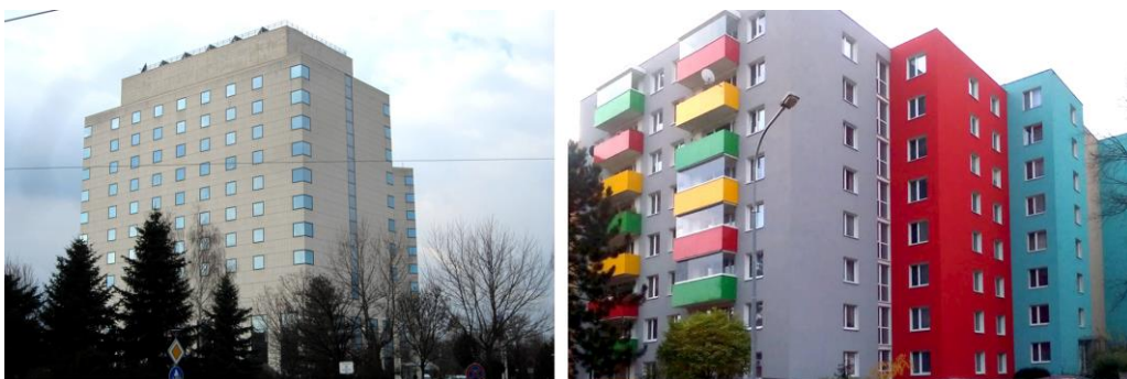
Фиг. 7. Сграда с прозрачни и плътни част в една равнина, София – вляво, Безрамково остъкляване на балкони в жилищен блок, Бърно, Чехия – вдясно
