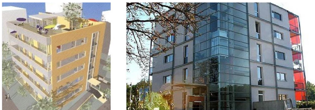
Фиг. 5. Енергоефективна сграда в гр. Улм, Германия, с отопляем обем, поместен в куб с размери 15 \times 15 \times 15 m (вляво – проект, визуализация; вдясно – реализация)
