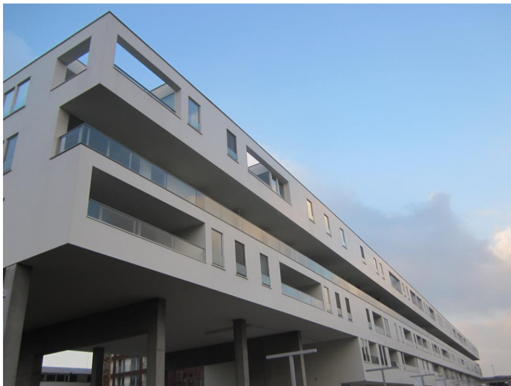
Фиг. 9. Жилищна сграда с фасадно термо-керамично покритие SuperShield Exterior
