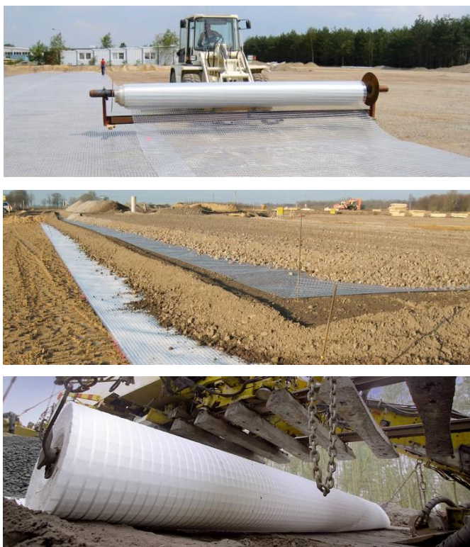
Фиг. 2. Функции на геомрежа “Secugrid“ – усилване на основа; усилване на основа с два пласта; усилване на основа в железопътно строителство [2]
