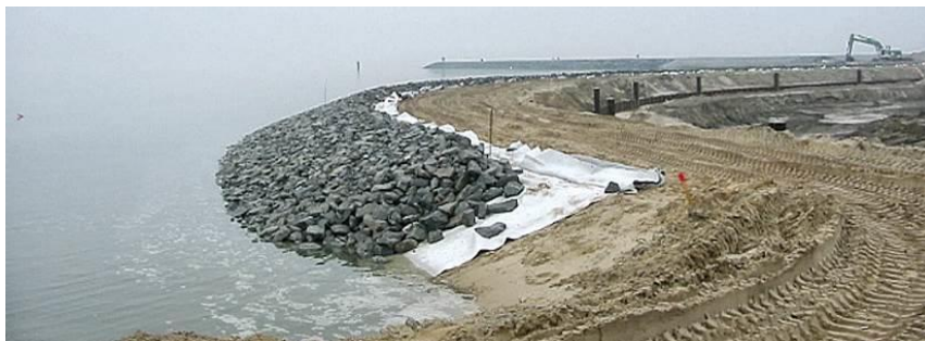
Фиг. 7. Геотекстил със затежаващ пласт [2]
