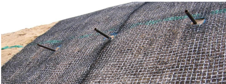
Фиг. 21. Укрепване на откоси: комбинация геомрежа и ерозионна рогозка [2]
