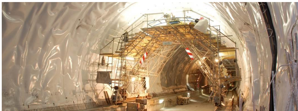
Фиг. 10. Функции на геомембрана “Carbofol®” – изолиране на тунели [2]
