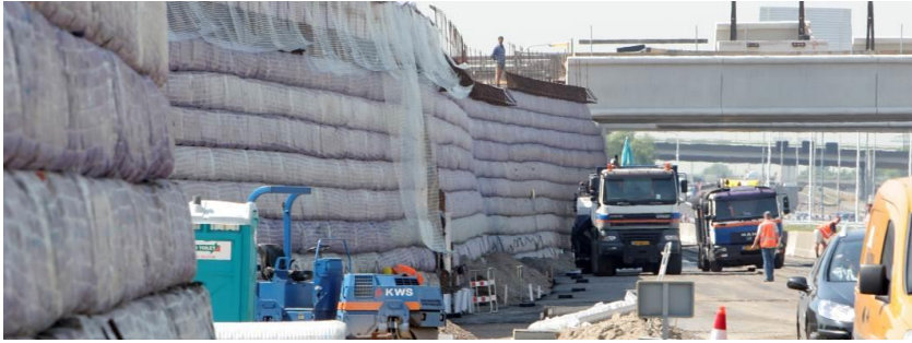
Фиг. 23. Армонасипна стена с „вертикален“ наклон от 89^\circ [2]
