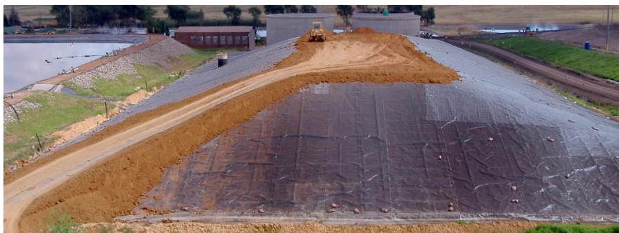
Фиг. 30. Конструкция на депо за отпадъци [2]
