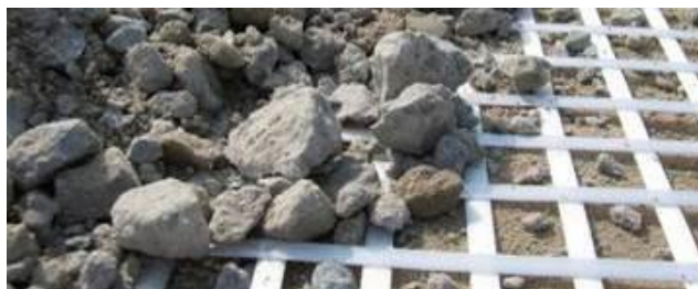
Фиг. 15. Усилване с геомрежа – ефект “interlocking” – заключване на насипният материал в структурата на усилваща геомрежа [2]
