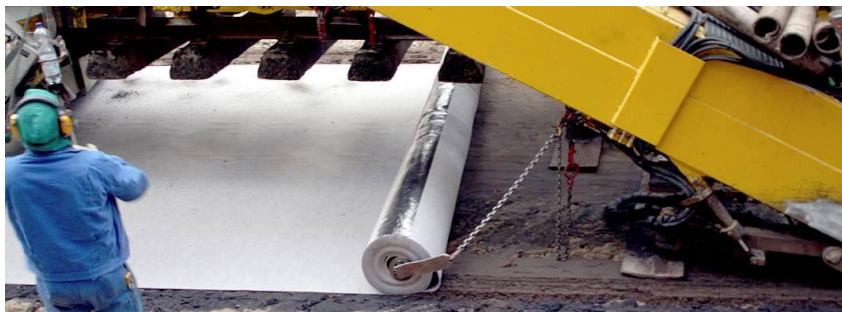
Фиг. 5. Геотекстил с интегриран радарно засичан слой [2]
