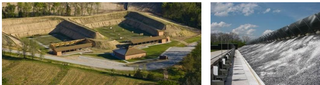
Фиг. 25. Шумозащитни земно-насипни стени, стрелбищен комплекс, Луизиана [3]
