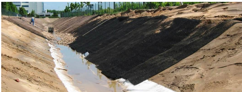
Фиг. 20. Укрепване на откоси с ерозионна рогозка “Secumat®“ [2]
