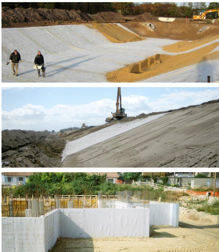
Фиг. 12. Функции на бентонитов геоекран “Bentofix“ – изолиране на депа за отпадъци/резервоари, изолиране на основи [2]
