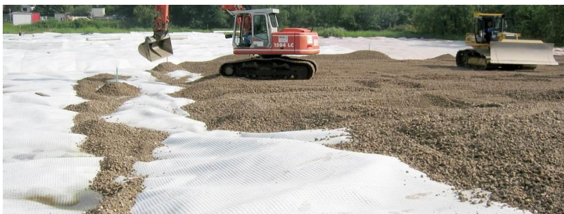
Фиг. 16. Усилване на основа [2]
