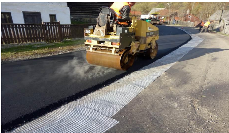
Фиг. 18. Полагане на мрежа за асфалт [2]
