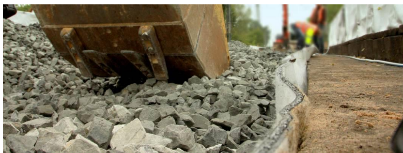
Фиг. 6. Баластов геотекстил [2]
