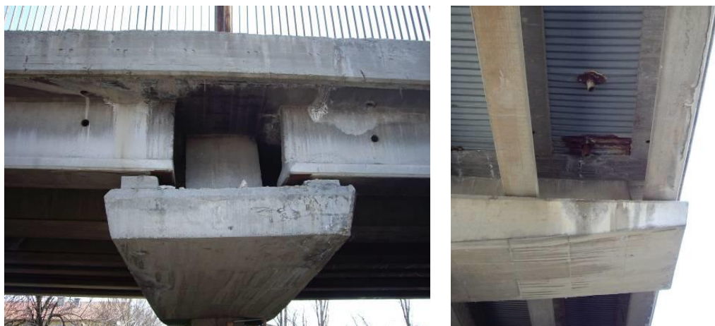
Фиг. 6. Мост, кв. „Бакърена фабрика“ – гр. София
