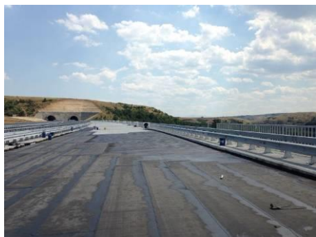
газопламъчно залепване на хидроизолационната мембрана
