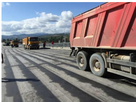
изпитване на готовата хидроизолационна повърхност
