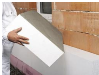
Фиг. 6. Фасадна шумоизолационна плоча „Austrotherm EPS® FS“ на „AUSTROTHERM“ [13]
