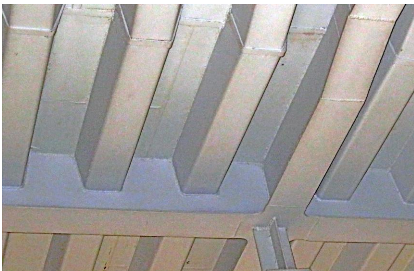
Фиг. 4.3. Детайл на връзка между трапецовидни надлъжни ребра и напречна греда от ОПШ – снимка от 2016 г.
