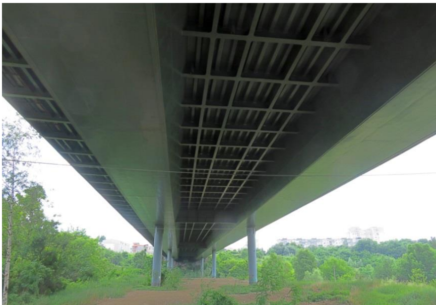
Фиг. 1.4. Стоманен мост с ОПП при парк „Въртопо“, гр. София, 1999 г.
