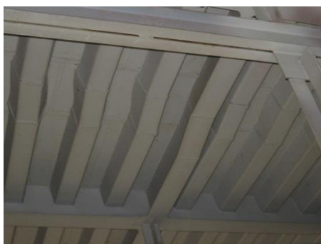
Фиг. 2.6. Монтажно снаждане при стоманен мост по АМ Хемус на km 26+884
