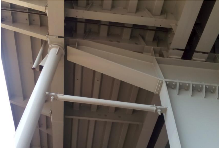
Фиг. 1.2. Стоманен мост с ОПП в гр. Елин Пелин (снимка – инж. Нина Постолова)
