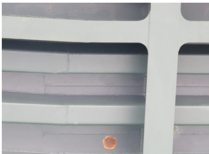
Фиг. 4.1. Заваръчни шевове между листове от пътната плоча на ОПШ и трапецовидни надлъжни ребра – снимка от 2017 г.
