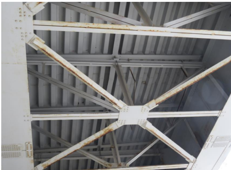
Фиг. 1.3. Стоманен мост с ОПП по АМ Хемус на km 26+884
