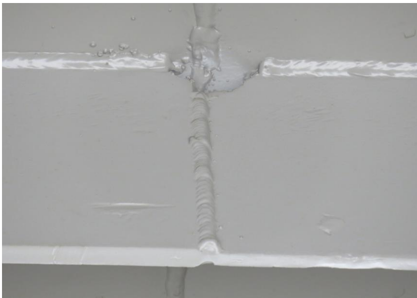
Фиг. 4.2. Свързване на плоски надлъжни ребра и листове на пътна плоча в ОПШ в рамките на един монтажнен елемент – снимка от 2017 г.
