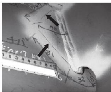
Фиг. 2.8. Уморна пукнатина в зоната на изреза при пресичане на напречна греда и надлъжно ребро от ОПП [11]
