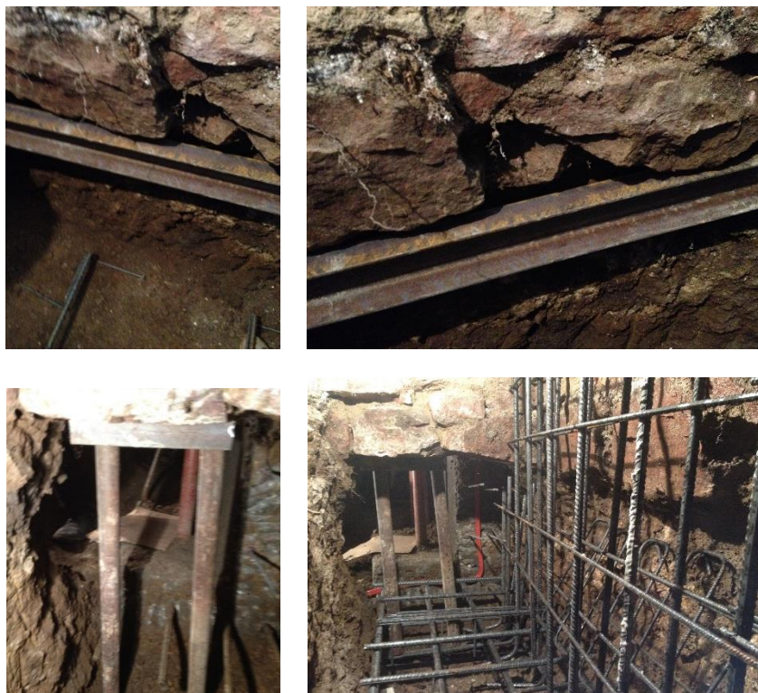
Фиг. 9. Изпълнение на фундаменти и стени
