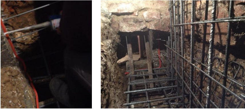
Фиг. 10. Изпълнение на фундаменти и стени
