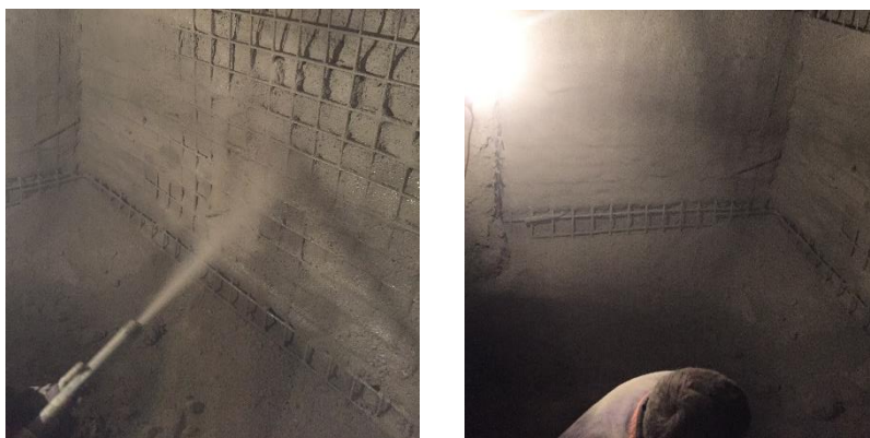
Фиг. 7. Изпълнение на торкретиране на стена
