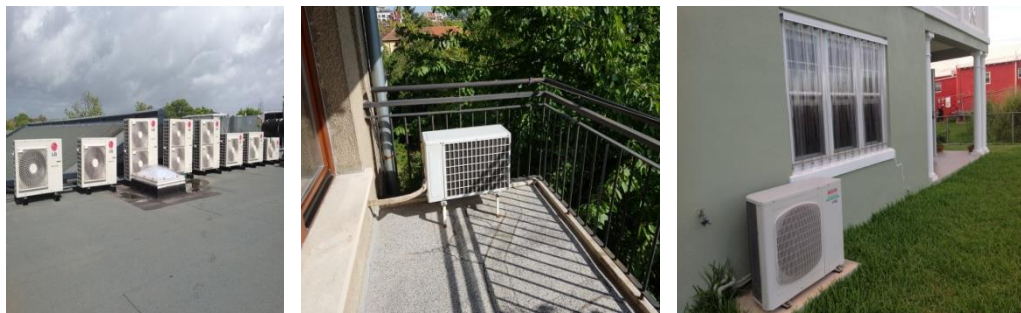
Фиг. 4. Монтиране на външно тяло върху покрив, под на балкон и в благоустроена площ
