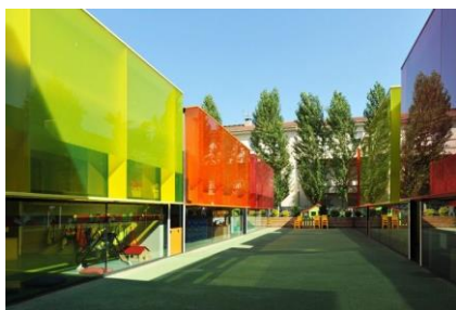
Фиг. 13. Els Colors Kindergarten, Барселона, Испания, RCR Arquitectes
