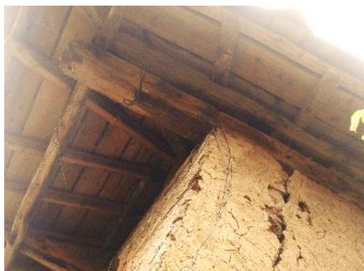
Фиг. 31. Конзолно излизане на горната греда на паянтовата стена (с. Долен)
