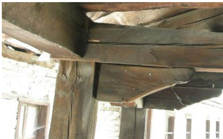
Фиг. 12. Възглавници при крайна колона от чардака без конзолна част (Чурилковата къща, с. Ковачевица)
