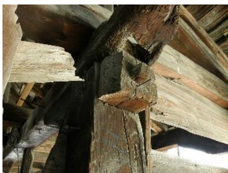
Фиг. 13. Възглавница при крайна колона от чардака с конзолна част (Чурилковата къща, с. Ковачевица)
