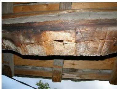
Фиг. 8. Колоната е демонтирана, при което сглобката между колоната и възглавницата е видима (Джаровата къща, с. Долен)
