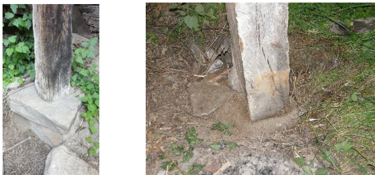
Фиг. 16. Опиране на колоните върху каменни фундаменти (с. Ковачевица и с. Лещен)
