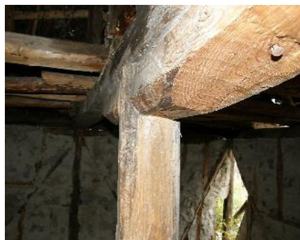
Фиг. 11. Връзка между възглавница и греда чрез гвоздеи (с. Делчево)
