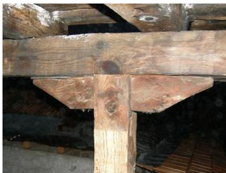
Фиг. 10. Връзка между колона и възглавница с двойно зарязване и гвоздеи (с. Делчево)
