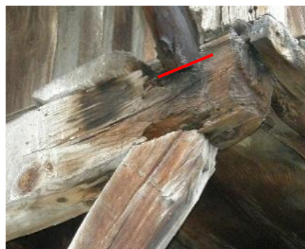
Фиг. 22. Греда, подложена на гниене, при което сглобката с подкоса намалява носимоспособността си (Нурковата къща, с. Делчево)
