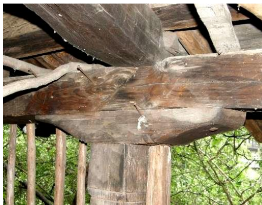
Фиг. 2. Снаждане на греди по дължина (с. Лещен)
