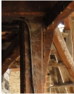
Фиг. 17. Накладка, която не е в контакт с колоната (Чурилковата къща, с. Ковачевица)
