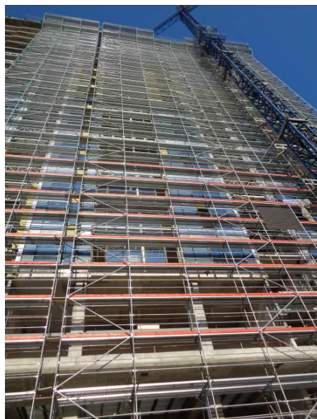
Фиг. 15. Рамково скеле със затворени рамки
