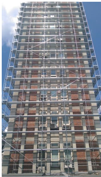
Фиг. 11. Фасадно скеле – фасада северозапад
