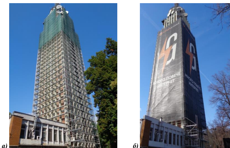
Фиг. 16. Изпълнено фасадно скеле
