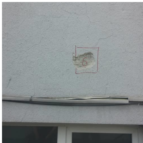
Фиг. 2. Общ вид на подготвен за изпитване стоманобетонен елемент
