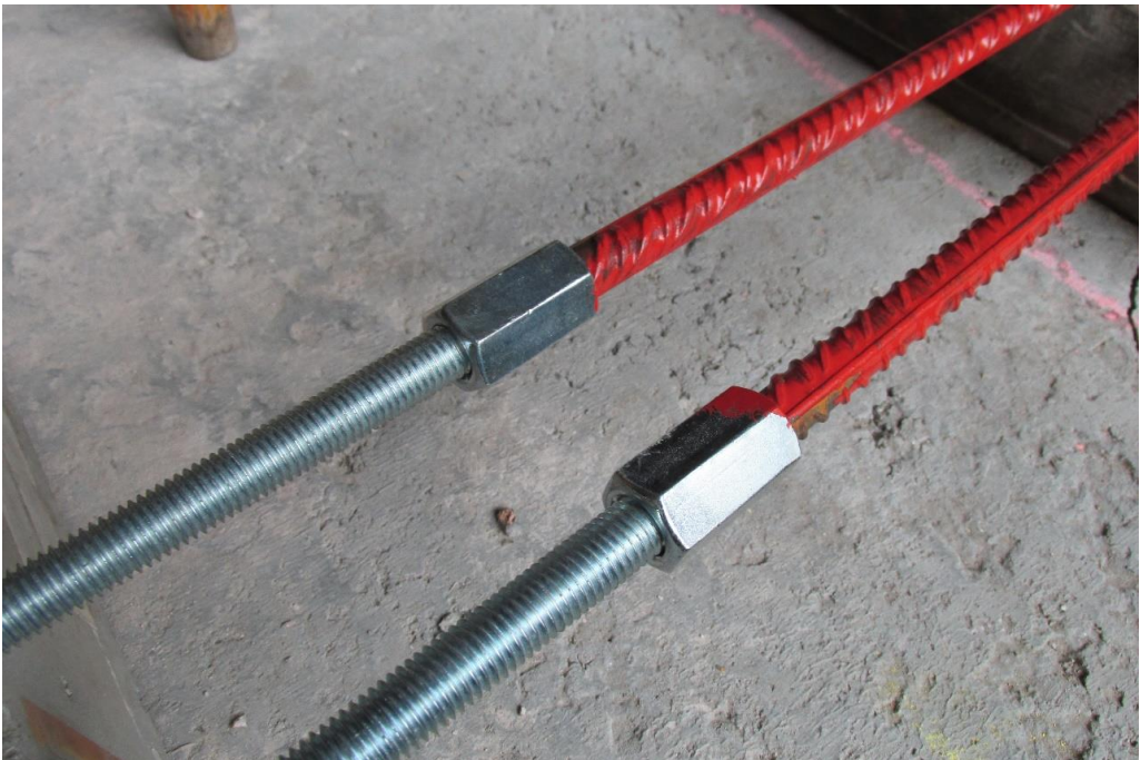
Фиг. 5. Муфа, свързваща напрегащата армировка и шпилките
