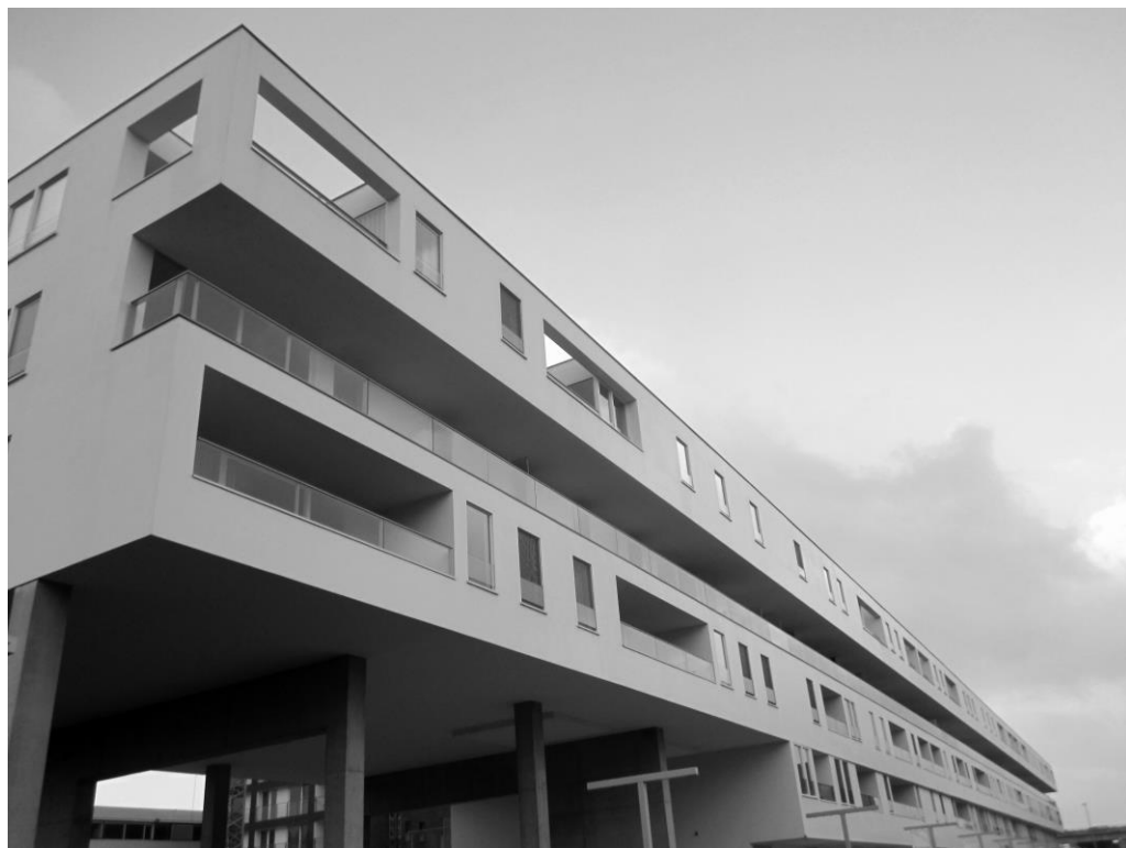
Фиг. 10. Жилищна сграда с фасадно термо-керамично покритие SuperShield Exterior
