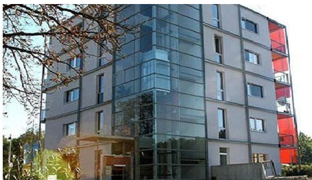
Фиг. 3. Енергоэффективна сграда в гр. Улм, Германия, с отопляем обем, поместен в куб с размери 15 \times 15 \times 15 m (вляво - проект, визуализация; вдясно - реализация)
