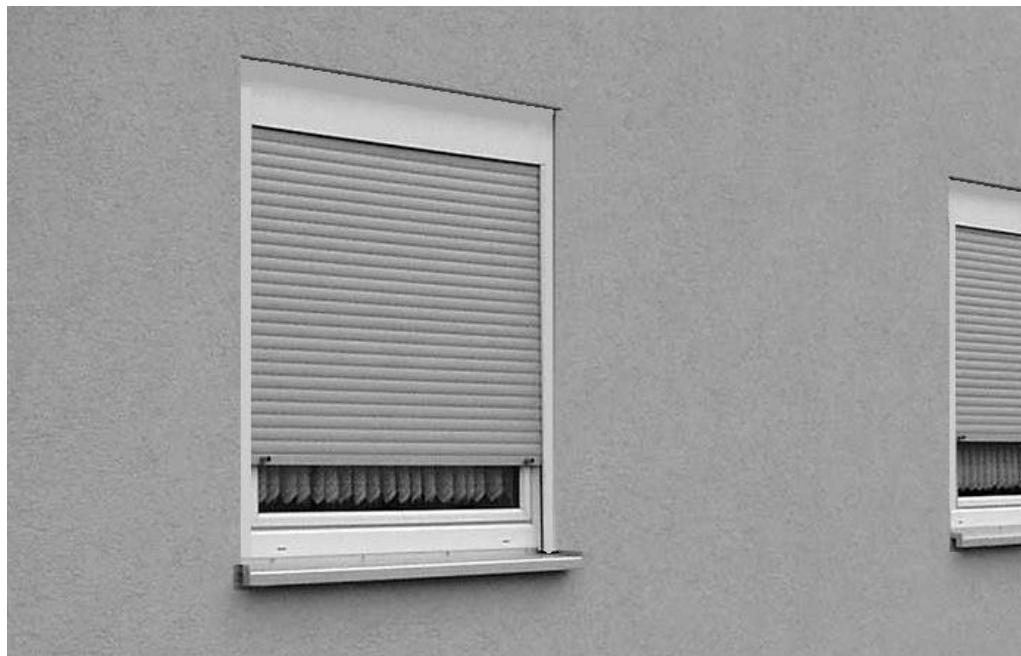
Фиг. 7. Външни ролетни щори, монтирани изравнено с плоскостта на фасадата
