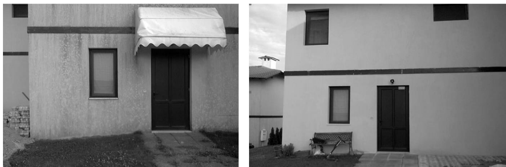
Фиг. 11. Фасадна плоскост, подлежаща на хронично овлажняване (вляво – без обработка с ТКП, където се наблюдава на микроводорасли и плесени и вдясно – след нанасяне на ТКП SuperShield Exterior ефективна защита от микроводорасли, плесени и мухъл)
