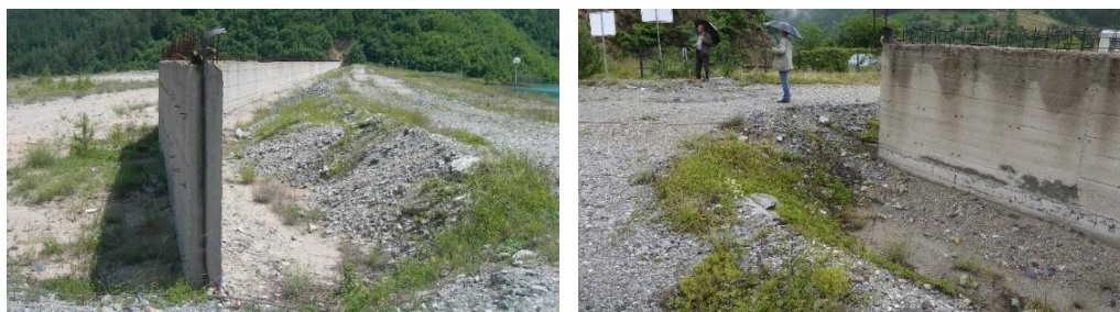
Фиг. 6. Поглед към съществуваща стоманобетонна диафрагма
