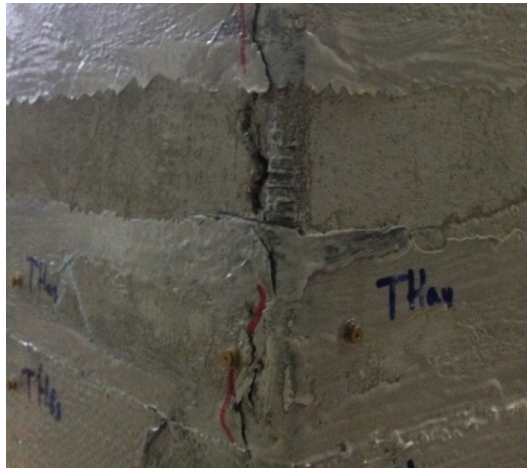
Фиг. 9. Вертикална пукнатина под усилващата лента
