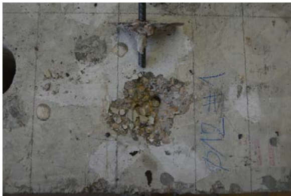
Фотос 4. Химически анкер Ø12-1, бетон клас С16/20
