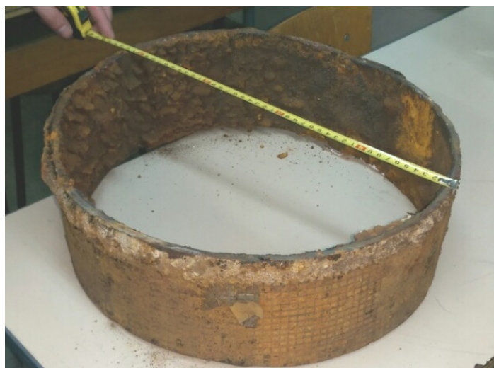
Фиг. 1. Снимка на корозирал стоманен водопровод \Phi 425 mm, в експлоатация от 1986 г. (местоположение - ул. „Св. св. Кирил и Методий”, района на Сточна гара)
