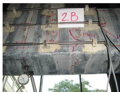
Разрушение в усилен елемент
