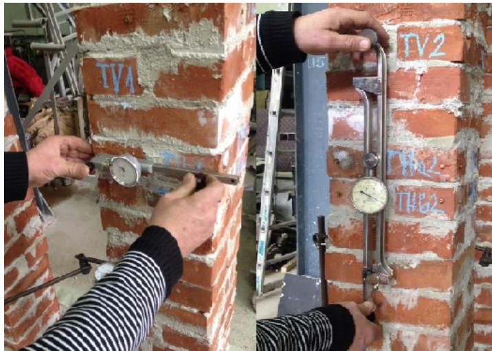
Фиг. 7. Пукнатини в колона 1
