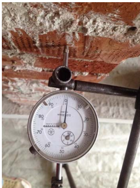
Фиг. 8. Измерване на хоризонталните деформации
