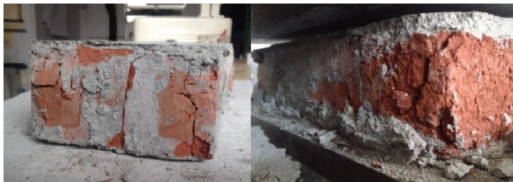
Фиг. 3. Ниво на визуални пукнатини в обмазаните пробните тела, при което те достигат разрушение
