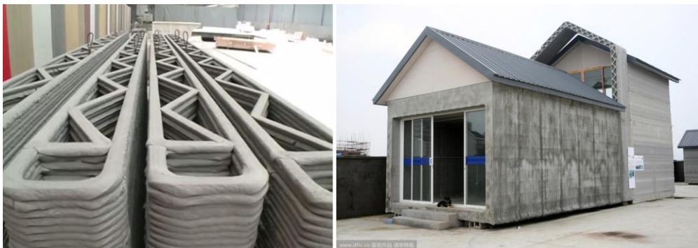
Фиг. 4. Строителни елементи и първа малка къща на китайската фирма Winsun, 2015 г. [5]
