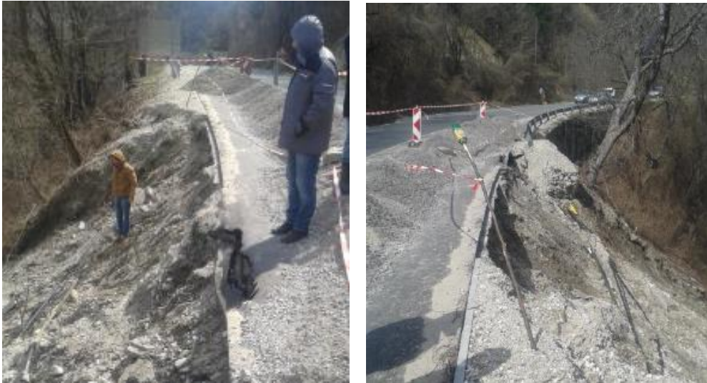
Фиг. 9. Свличане на пътния насип [1]
