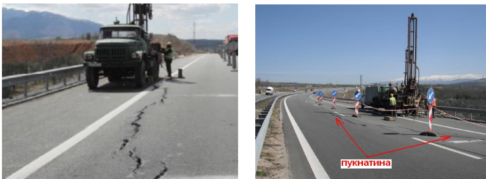
Фиг. 1. Състояние на пътното платно на АМ „Струма“ в засегнатия участък [2]
