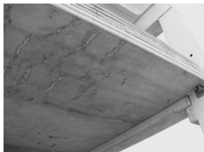
Фиг. 3. Поглед към провисналото и напукано поле 2-3/Г-Д
