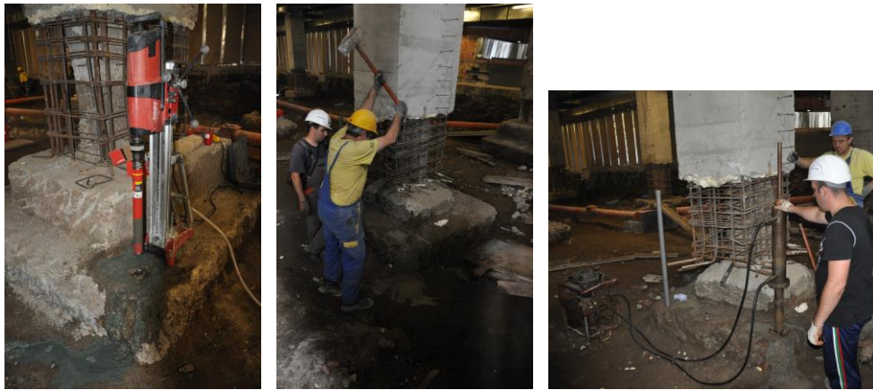
Фиг. 8. Пробиване на фундамент MF1 чрез диамантена боркорона, набиване на щанги и изваждането им чрез хидравлична система
