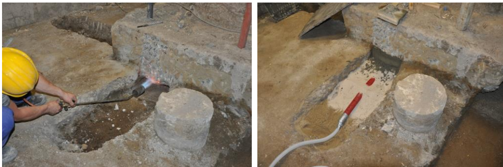
Фиг. 4. Обгаряне на основната плоскост на съществуващите фундаменти и инсталиране на pressure cell датчик под фундамент MF1
