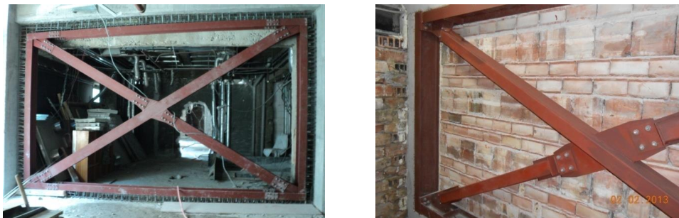
Фиг. 2. Типова вградена вертикална стоманена връзка
