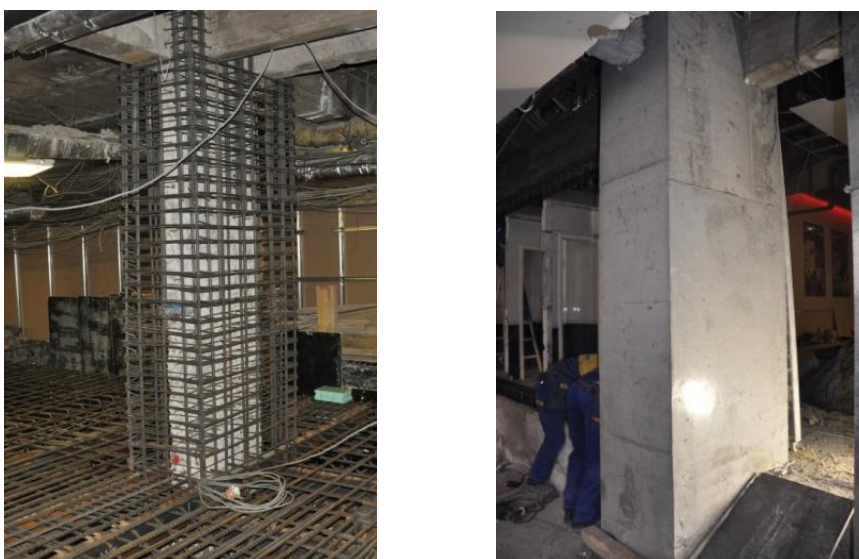
Фиг. 3. Усилване чрез стоманобетонни кожуси
