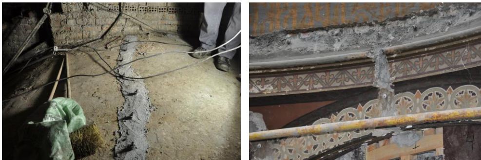
Фиг. 7. Запълване на пукнатини чрез разтвор с компенсирано съсъхване
