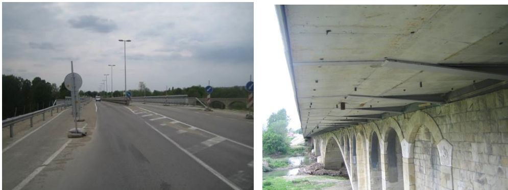
Фиг. 11 Разширение на моста над р. Янтра при гр. Бяла
