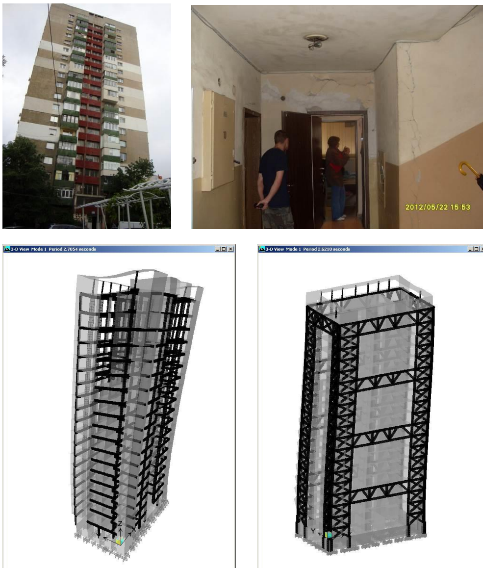
Фиг. 13. Обследване на високи сгради в София и решения за възстановяване на земетръсната им устойчивост
