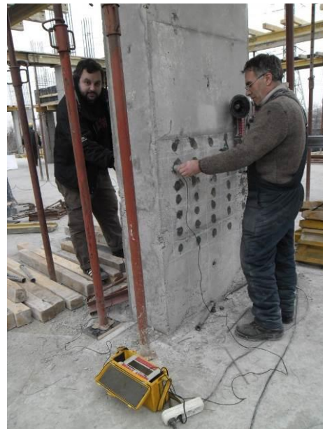
Фиг. 8а,б,в. Обследване за възстановяване на строяща се промишлена сграда в София
