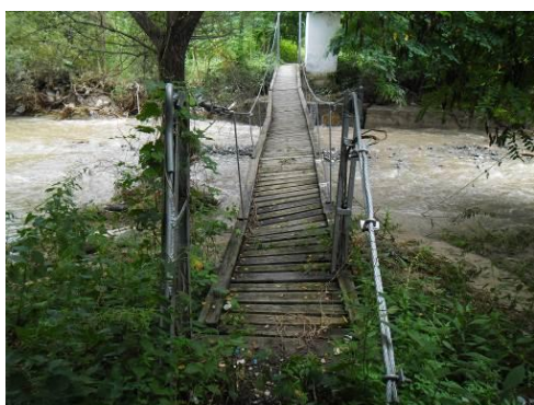
Фиг. 23 и 24. Опасни за използване пешеходни мостове в с. Храбрино – висящ над р. Тъмръшка и стоманен гредов над р. Дедевска при 7-ма улица
