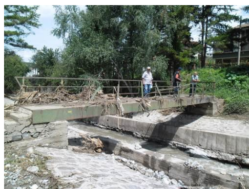
Фиг. 23 и 24. Опасни за използване пешеходни мостове в с. Храбрино – висящ над р. Тъмръшка и стоманен гредов над р. Дедевска при 7-ма улица
