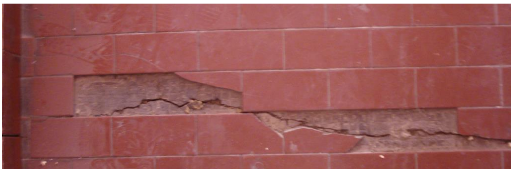
Фиг. 2. Технологична фуга в подава конструкция
