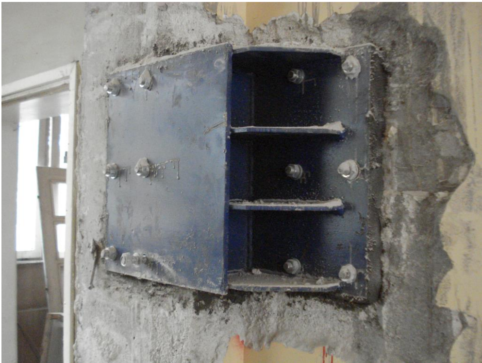
Фиг. 6. Стоманен групов дюбел в комплексна шайба
