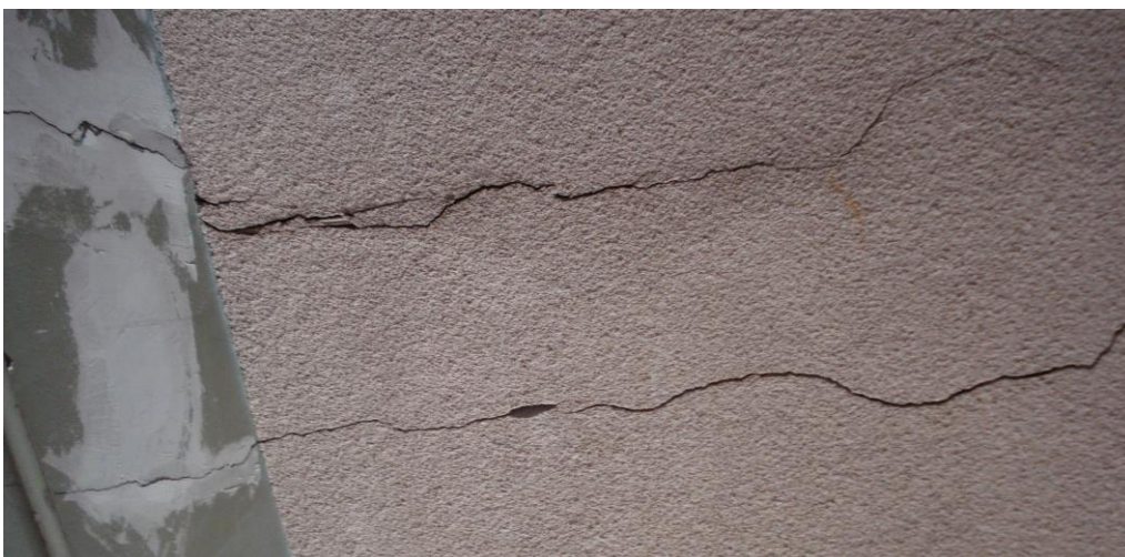
Фиг. 3. Замонолитена технологична фуга
