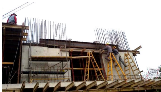
Фиг. 8. Изпълнение на комбинирана стоманобетонна греда
