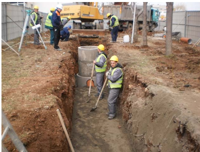
Фиг. 1. Част от строителната площадка по време на изграждане на канализация
