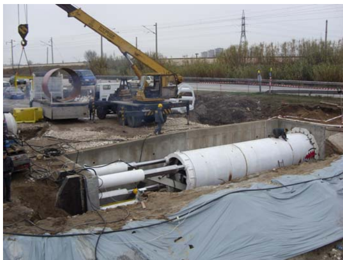
Фиг. 4. Горизонтален сондаж под път
