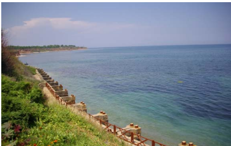
Фиг. 3. Изглед към изградената брегозащитна стена
