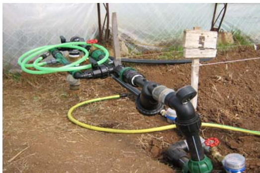
Фиг. 1. Команден възел на системата за подпочвено капково напояване
