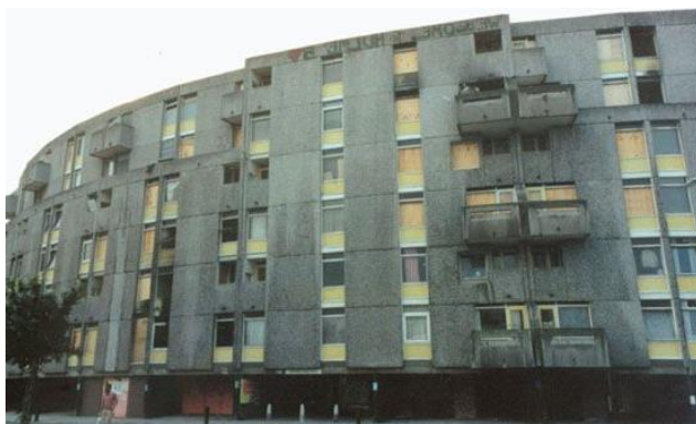
Фиг. 4. Компрометираны изолации в панелен блок в кв. Хюлм, Манчестър
