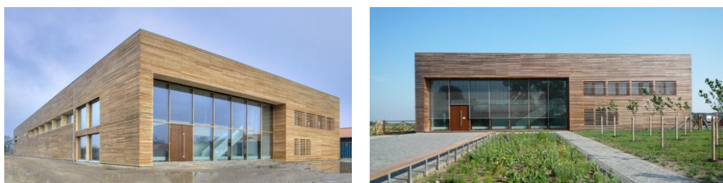
Фиг. 3. Входна фасада на състелена ферма в Мюнхенхофе – Германия
