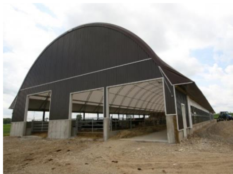
Фиг. 13. Кравеферма с тъканно покритие – Lammers Dairy Inc. Harold & Susan Lammers, Palmerston – Онтарио, САЩ
